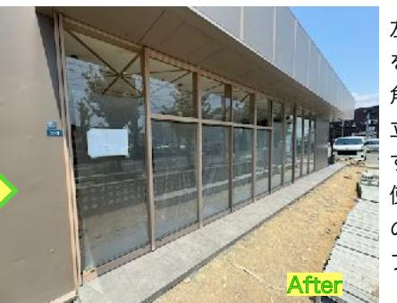
左の写真が、既設サッシを残したまま、内外から角パイプを使って擬似方立を作ったものになります。既設上げ下げ窓は使わないので固定し、窓の凹凸に合わせて角パイプを組み合わせました。
